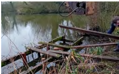
Oude planken zijn verwijderd
